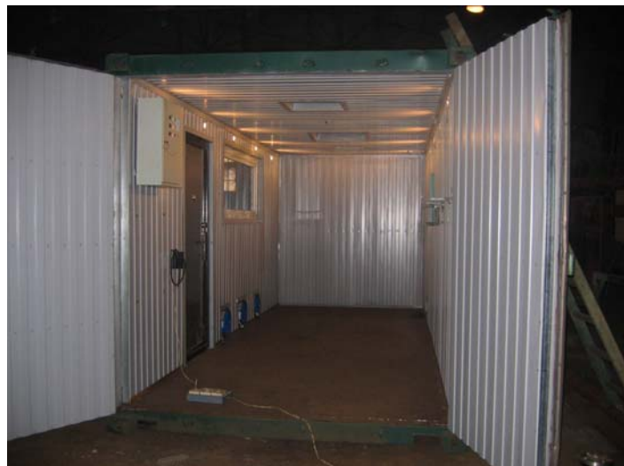
Подготовленный контейнер для монтажа МЭС
