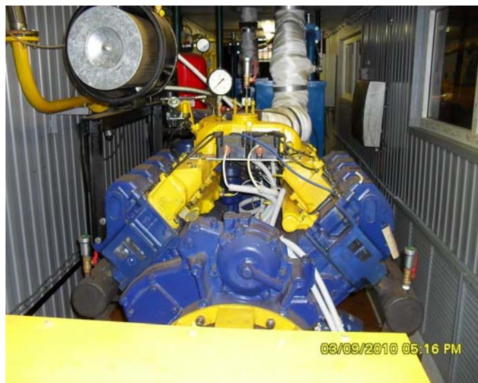
МЭС 250 на базе ЯМЗ 8424 в контейнере
